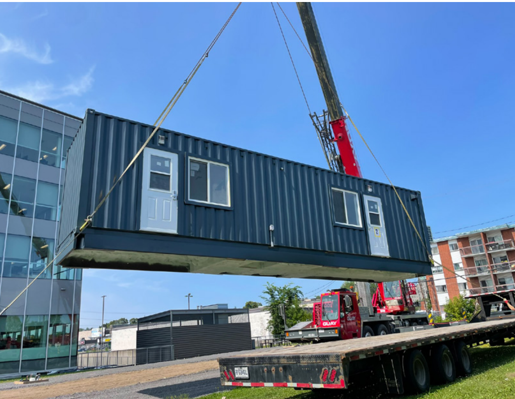
Déplacement d'une maison modulaire sur le site de Québec
