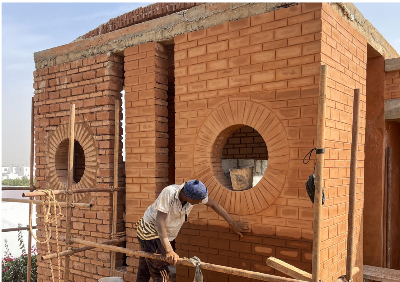
Logement réalisé en brique de terre par le cabinet d'architecture Worofila basé au Sénégal (Worofila, 2023)
