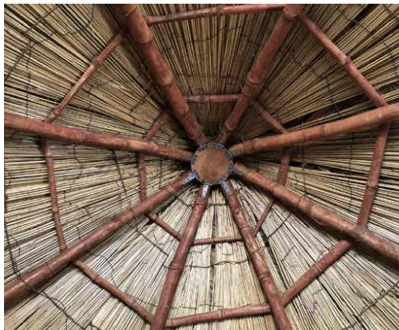
▼ L'intérieur du toit octogonal de la *chaunra* fait de bambou et de chaume.
