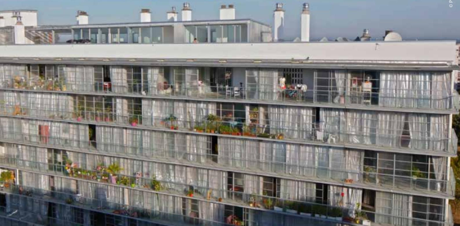
▼ Le projet du Grand Parc illustre la transformation d'un bâti existant jugé sans qualités en logements confortables et performants énergétiquement. Le coût de cette transformation est trois fois inférieur au montant nécessaire à sa démolition et à la reconstruction d'immeubles neufs.
