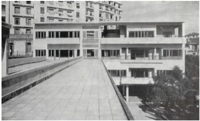
Figure 132 : École de garçons, école Emir Khaled, Alger, P-A Emery et C-A Breuillot, 1930 (CNA, 1930, p. 121)
