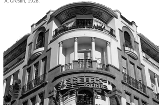
Immeuble rue Prince Moulay Abdalah, Casablanca.
