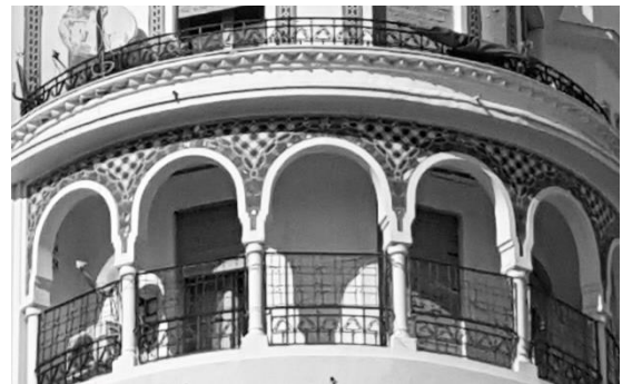
Figure 81 : Détail du décor de l'arcature de l'immeuble de la rue Aban Ramdan, Alger (auteur, 2019)
