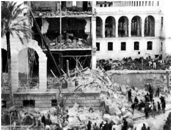
Figure 7 : Destructions de l'aile droite du lycée Bugeaud, Alger, 1942 (cagrenoble.fr)
